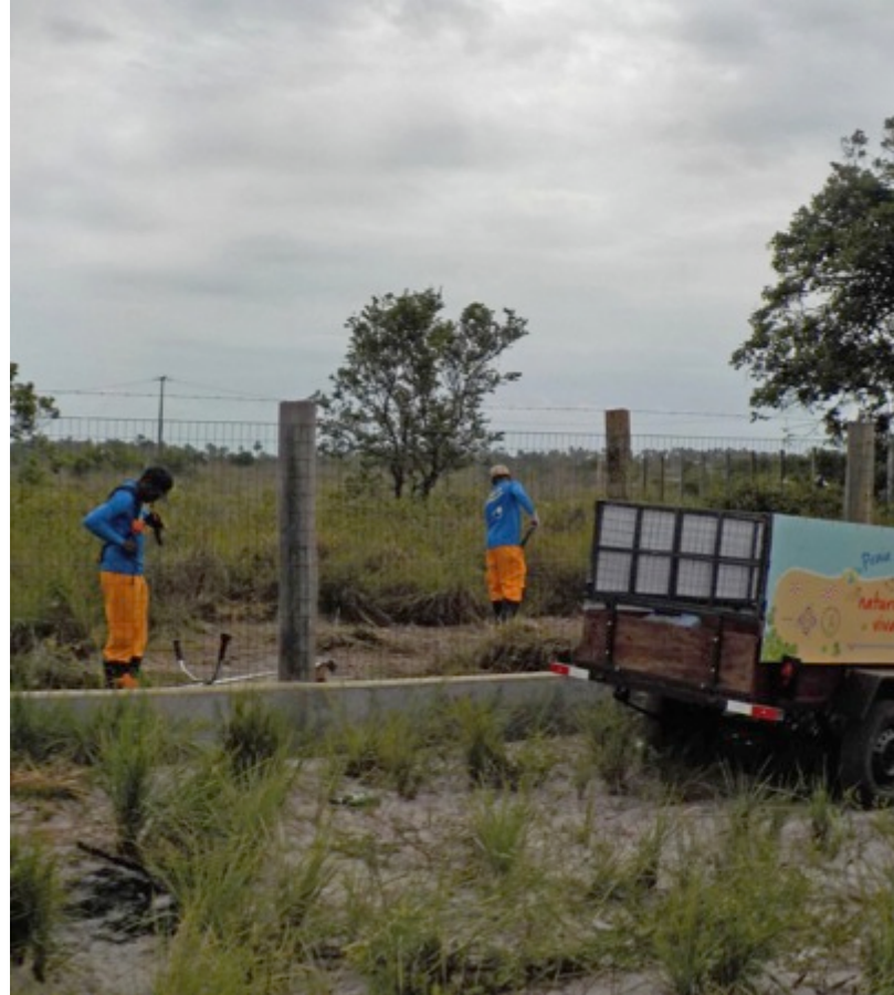
Limpeza do terreno de transbordo
